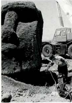
Foto 3. Aplicación de consolidante a cabeza de moai perteneciente al Ahu Tongariki. Fotografía: Mónica Bahamóndez.
