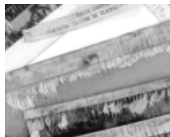
Foto 17: Placas afectadas durante la inundación.
