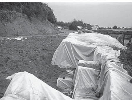
Foto 8. Relleno sobre el geotextil con sedimentos.
