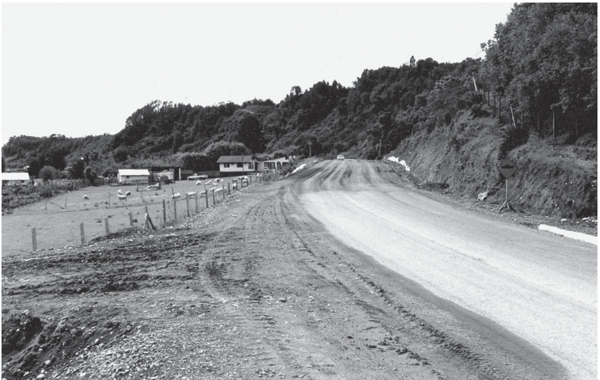
Foto 10. Vista del sitio cubierto por el nuevo camino.
