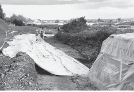
Foto 7. Instalación del geotextil sobre la base del depósito excavado.
