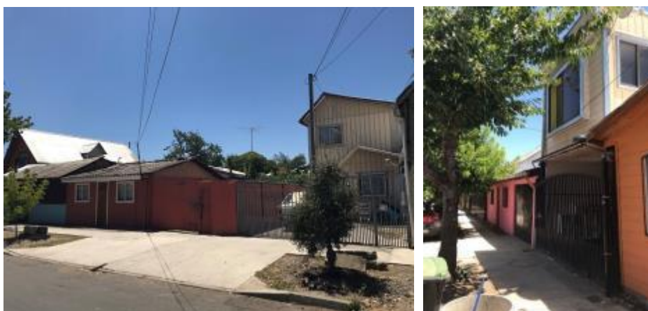
Fig.44. Estas 6 imágenes dan cuenta de las diversas tipologías de edificaciones de las viviendas que han sido transformadas o repuestas con materialidad y tipo de construcción contemporánea. Como se puede apreciar una gran parte de ellas son de dos pisos y de material liviano. Fotografías tomadas por el Consultor, febrero 2021.
