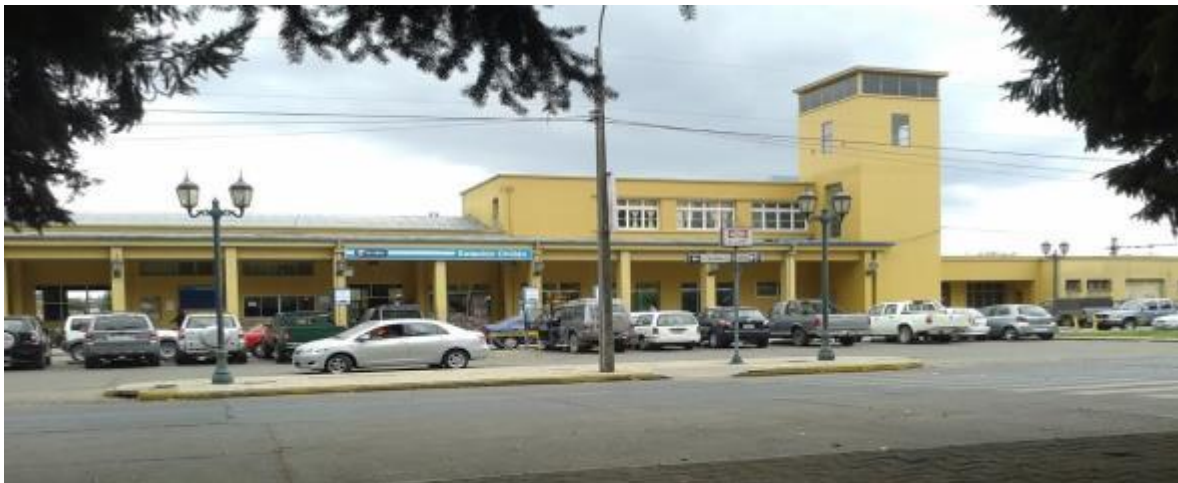
Fig.31. Vista frontal del edificio de la Estación con el atrio urbano de acceso conectado a la importante vía parque Avenida Brasil. Fuente: https://mapio.net/pic/p-103099918/
