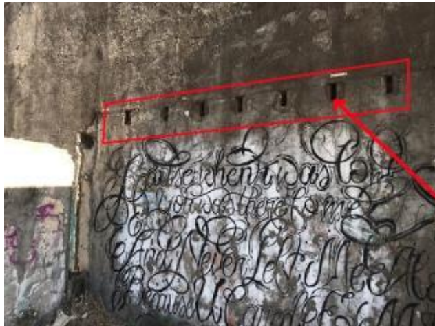
Esta imagen recalca vestigios del empotramiento de las vigas de estructura de cielo que tendría este recinto de oficinas.
