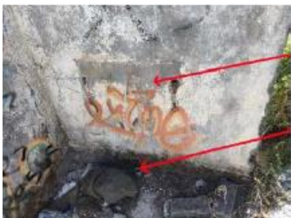
Detalle de vestigios del lavabo en baños de hombres, desagüe y de la sujeción del artefacto
