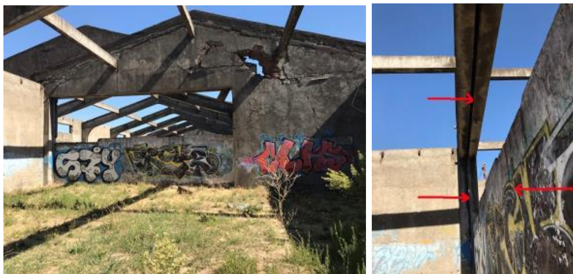
Fig.51. En con estas dos imágenes se aprecia el muro divisorio de las dos subunidades actuales. Por su junta con el muro y marco transversal en el mismo vano original de conexión del resto de los cuerpos originales y que no cubre la altura total, hace evidente que su integración fue posterior a la construcción
