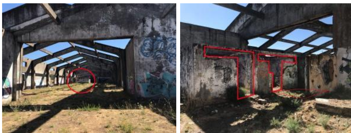
Fig.53. En la imagen de la izquierda se observa la Unidad de Servicios interna del cuerpo 3 de la subunidad B actual. La imagen de la derecha muestra una vista del frontis de ingreso a los dos recintos principales de esta unidad, con una intervención grafica que recalca los vanos originales de la puertas y ventana laterales que tenían estos recintos.
