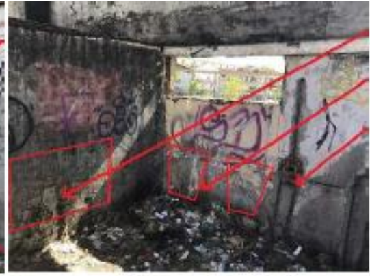
Vestigios en muros de la sujeción de estanques de WC a nivel de la taza y de lavabo colectivo en baño de hombres.
