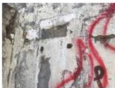
Detalle de uno de los dos estanques en Baño Mujeres
