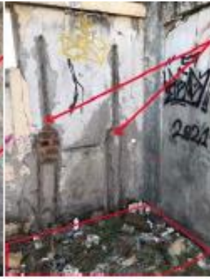
Vestigio de las cañerías de agua de la unidad de ducha colectiva en Baño de hombres.
