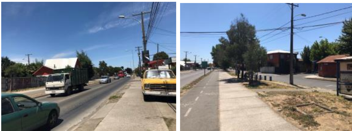
Fig.40. Estas dos imágenes muestran la situación actual del límite poniente con la Avenida Martín Ruiz de Gamboa, que tiene un alto flujo vehicular con transporte público, que divide notoriamente el barrio, con los sectores residenciales hacia el poniente, lo cual transforma este límite en una barrera virtual de importancia. Fotografías tomadas por el Consultor, febrero 2021.
