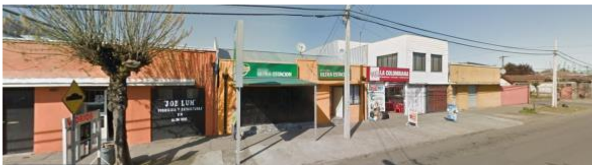
Fig.45. En estas 4 imágenes se puede apreciar un ejemplo en el barrio de galpón metálico de depósito de materiales de construcción (imagen superior Izq.), casos de comercio barrial de esquina (imagen superior Der. e imagen Central) y un conjunto de comercio continuo que incluye un Taller de Vidriería y Estructuras de Aluminio (imagen inferior.) Fuente: Imágenes recortadas de Street View de Google Maps y Fotografía tomada por el Consultor, febrero 2021.
