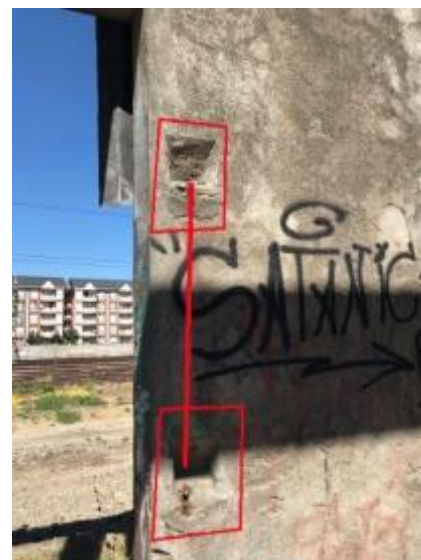
Fig. 64. En esta imagen, se aprecia vestigios del sistema de cerradura de los portones, que por el doble empotramiento, pudo tratarse de un sistema con palanca de doble cierre, superior e inferior.
