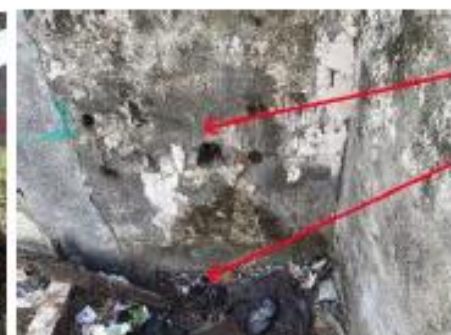
Detalle del lavabo mujeres de la cañería de suministro de agua y de sujeción del artefacto
