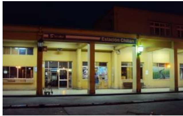
Fig.30. Vista frontal del acceso de la Estación, desde el centro histórico de la ciudad. Fuente: https://mapio.net/pic/p-85491286/
