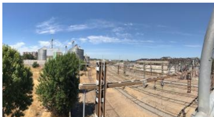
Fig.38. Vista actual desde la pasarela ya citada, en la cual se puede apreciar la permanencia de actividad industrial, con otros edificios industriales obsoletos y abandonados "al otro lado de la línea" pero hacia el lado sur de los terrenos del Estudio. Se aprecia una gran industria en funcionamiento en el lado oriente de la línea. Fotografía tomada por el Consultor, febrero 2021.
