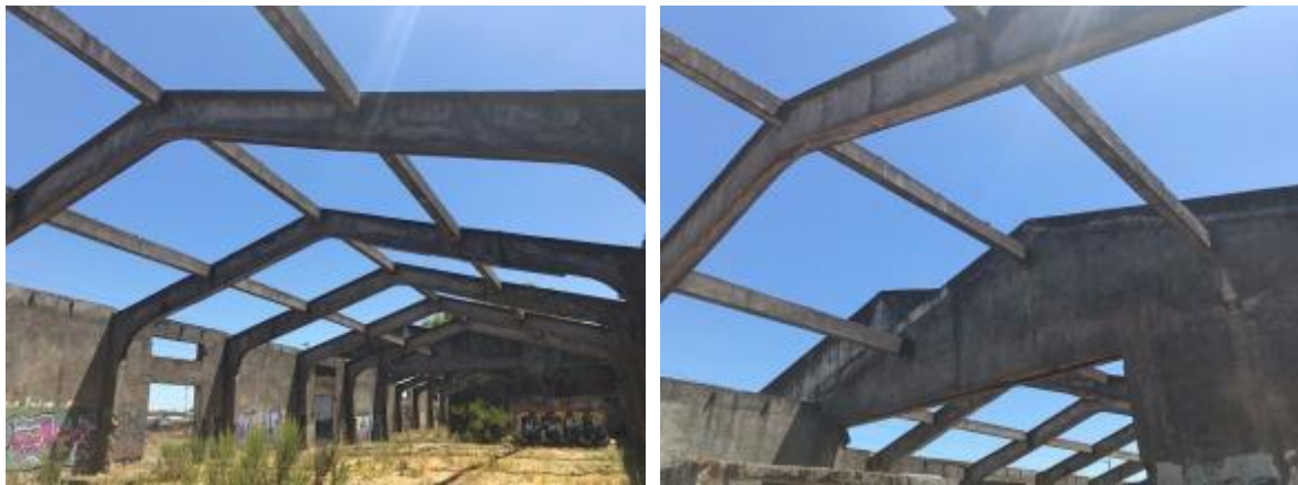
Fig.56. En con estas dos imágenes se aprecia la conformación de los marcos y las vigas secundarias
