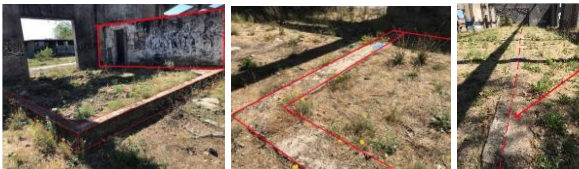
Fig.54. En la imagen de la izquierda vestigio de muro de un volumen que estaba adosado a la Unidad de Servicios interna del cuerpo 3 de la subunidad B actual. La imagen del centro da cuenta de vestigio de muro de un volumen que existía en el cuerpo 1 y la imagen de derecha da cuenta de la gran extensión de este mismo vestigio de este muro que se encontraba ubicado en el eje del cuerpo citado.
