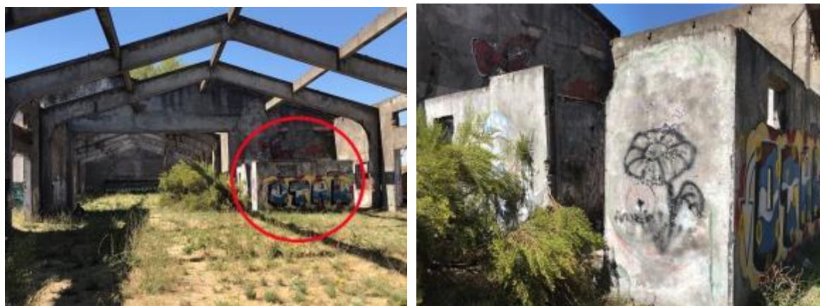
Fig.52. La imagen de la izquierda muestra una vista exterior de la Unidad de Servicios interna del cuerpo 2 de la subunidad A actual. En la imagen de la derecha se aprecia uno de los frentes esta unidad con los vanos de acceso al baño de mujeres (lado derecho de la foto y hombres (lado izquierdo).
