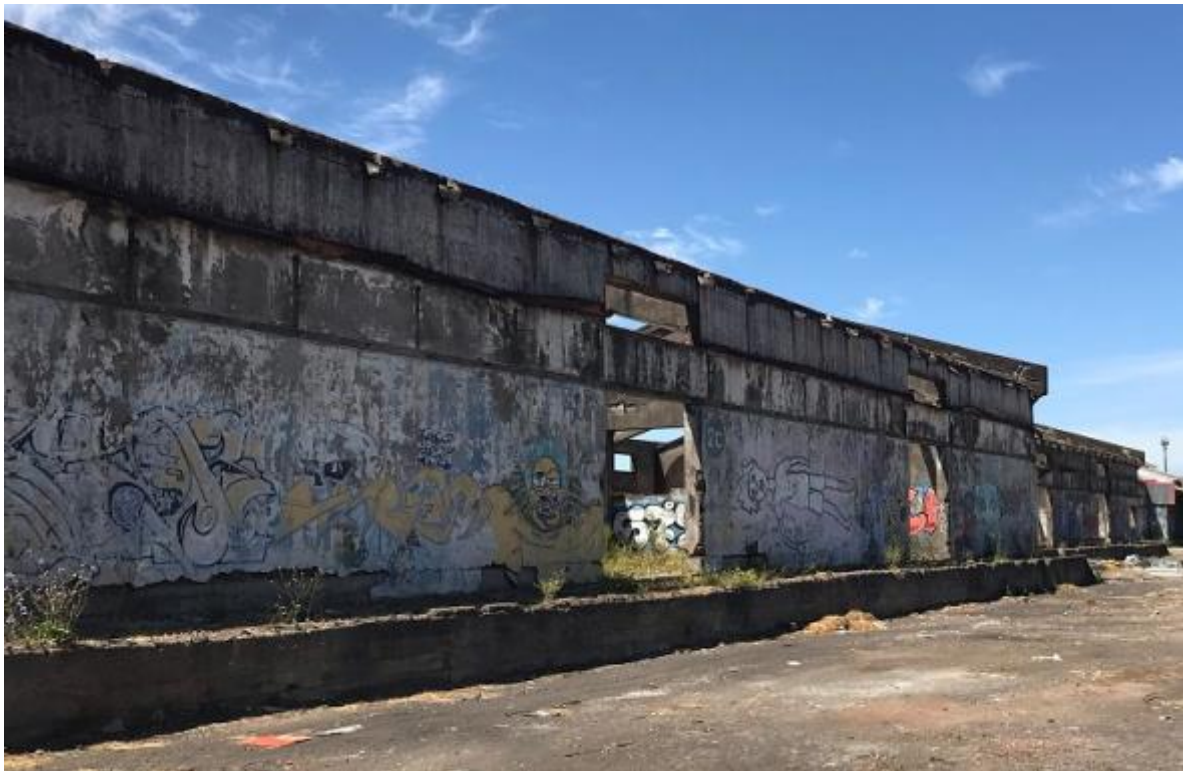
Fig.58. En esta imagen se aprecian los muros longitudinales revocados, el terraplén y los vestigios de la estructura metálica empotrada a estos muros, que soportaba el cobertizo en volado que tenían los pasillos exteriores laterales de las bodegas,
