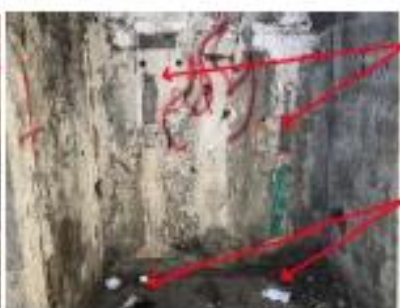
Vestigios de sujeción de dos estanques y desagües para WC en baño mujeres.
