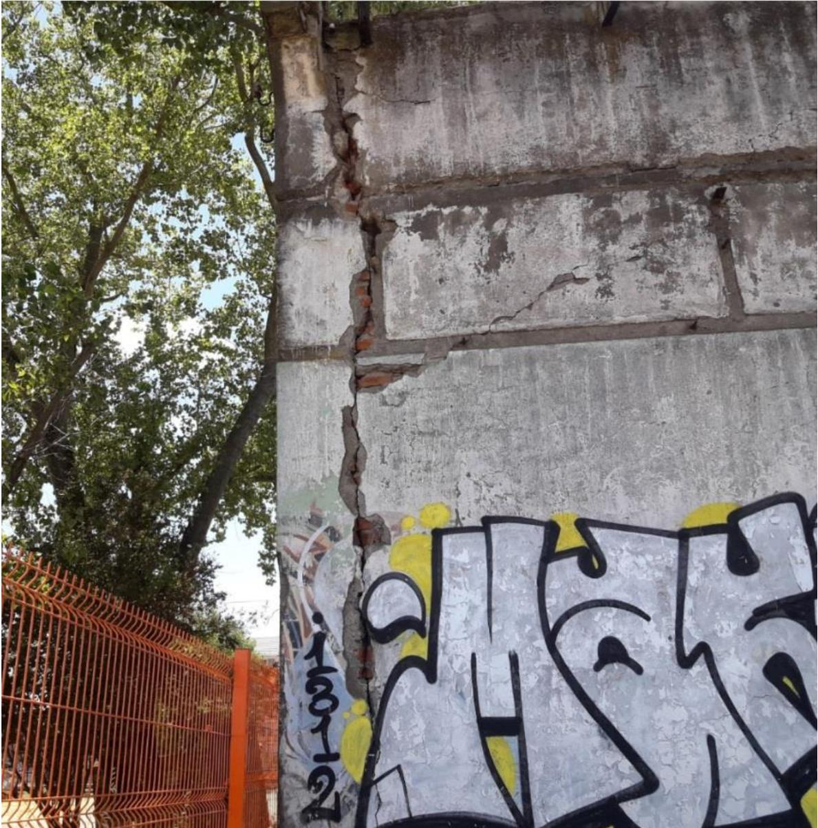
Muro norte de nave norte exhibiendo fractura vertical y diagonal. La primera se debe al exceso de deformación lateral de los muros longitudinales por las carencias de rigidez transversal. La segunda es plenamente coherente con la anterior y se debe a corte sísmico excesivo en el plano propio del muro.
