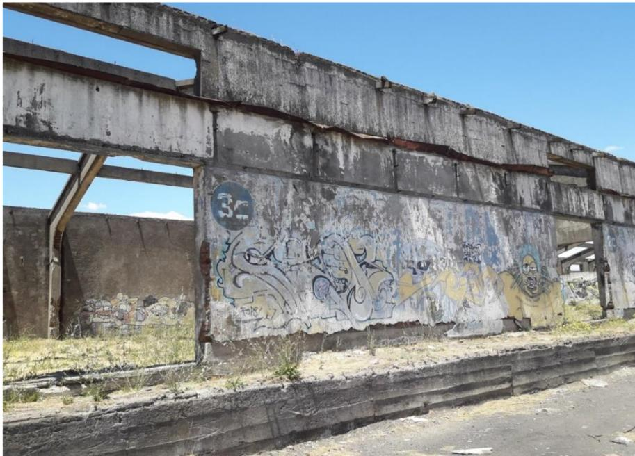
Fractura a nivel de sobrecimiento de muro longitudinal producto de la flexión lateral excesiva de éste.
