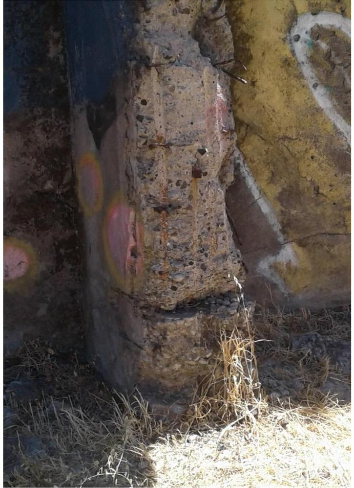
La extracción antrópica de las barras interiores inferiores de las columnas de los marcos es sistemática en el conjunto de naves.
