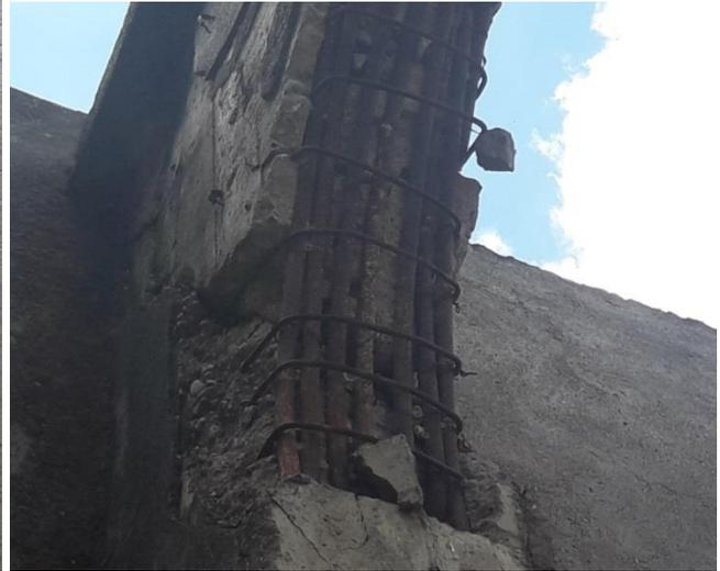
Sistemáticamente los hombros de los marcos presentan falla sísmica y exponen sus armaduras de acero liso.
