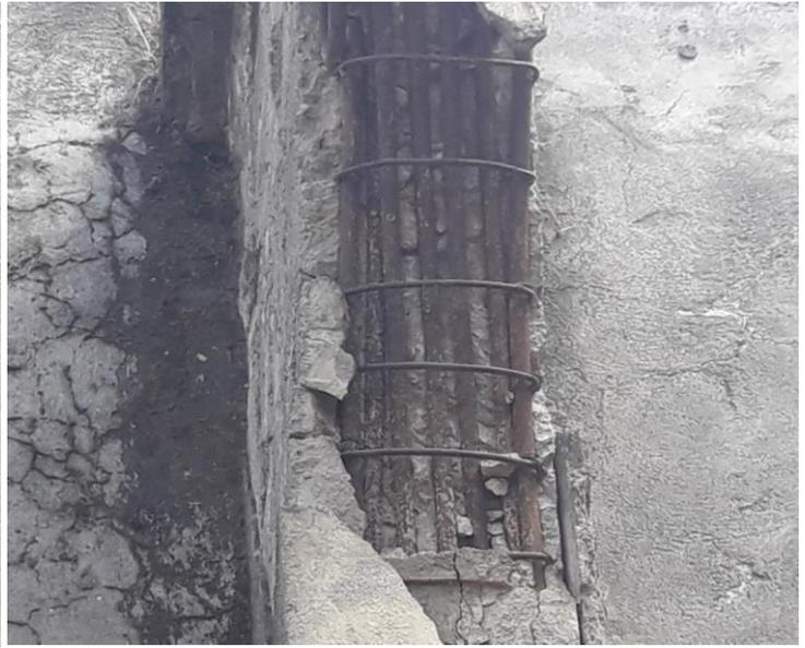
La falla sísmica en hombros es sistemática. No sólo implica la pérdida de recubrimientos, sino que el agrietamiento del hormigón.
