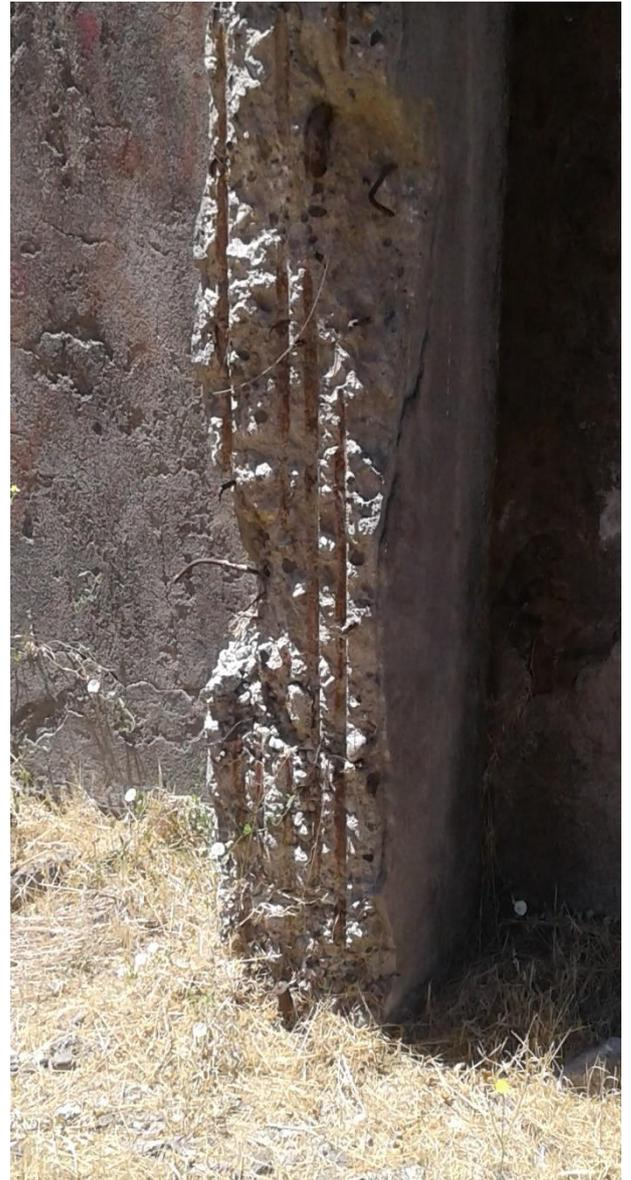
En estas fotografías se puede apreciar claramente el daño antrópico en la base de las columnas de los marcos transversales.
