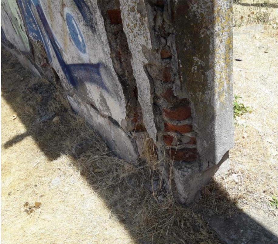
Se constata carencia de pilares de confinamiento en extremos de muros longitudinales.
