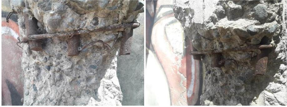
Extracción de armaduras verticales en pilares.
