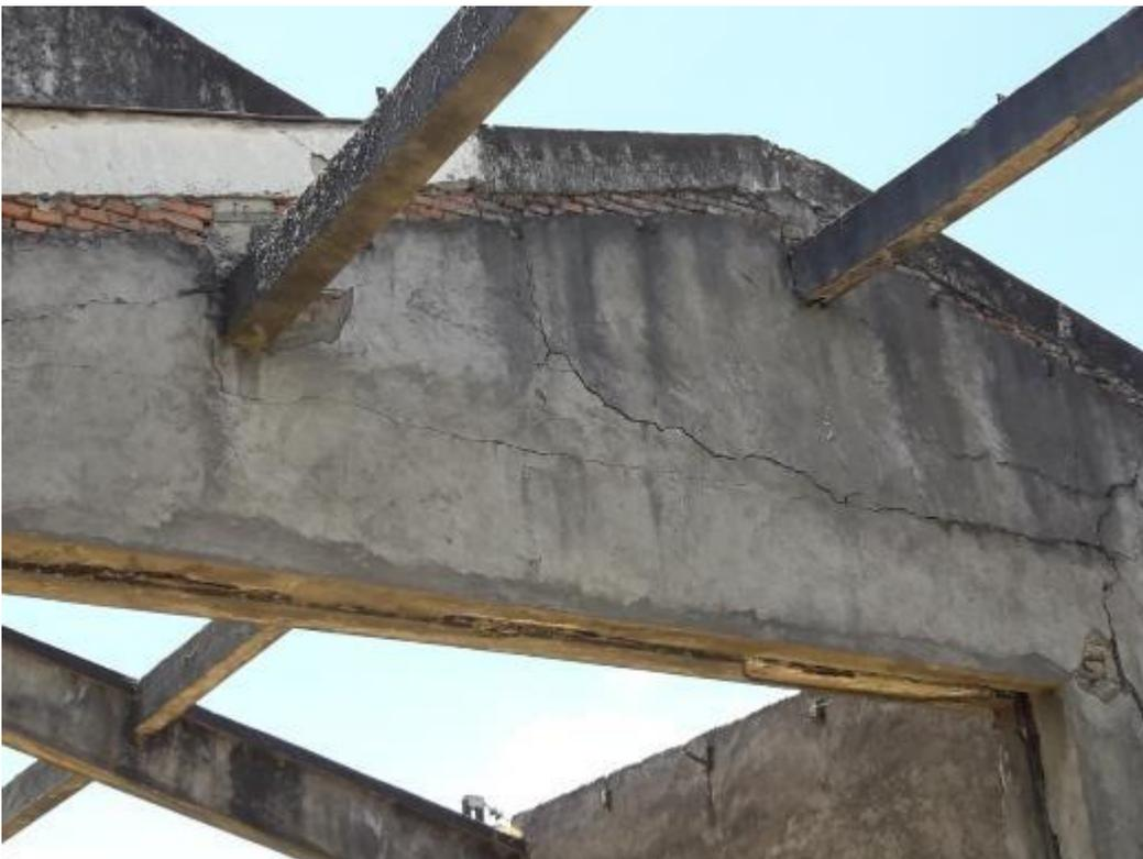
En esta imagen se puede apreciar la cadena inclinada de coronamiento del frontón, en buenas condiciones.
