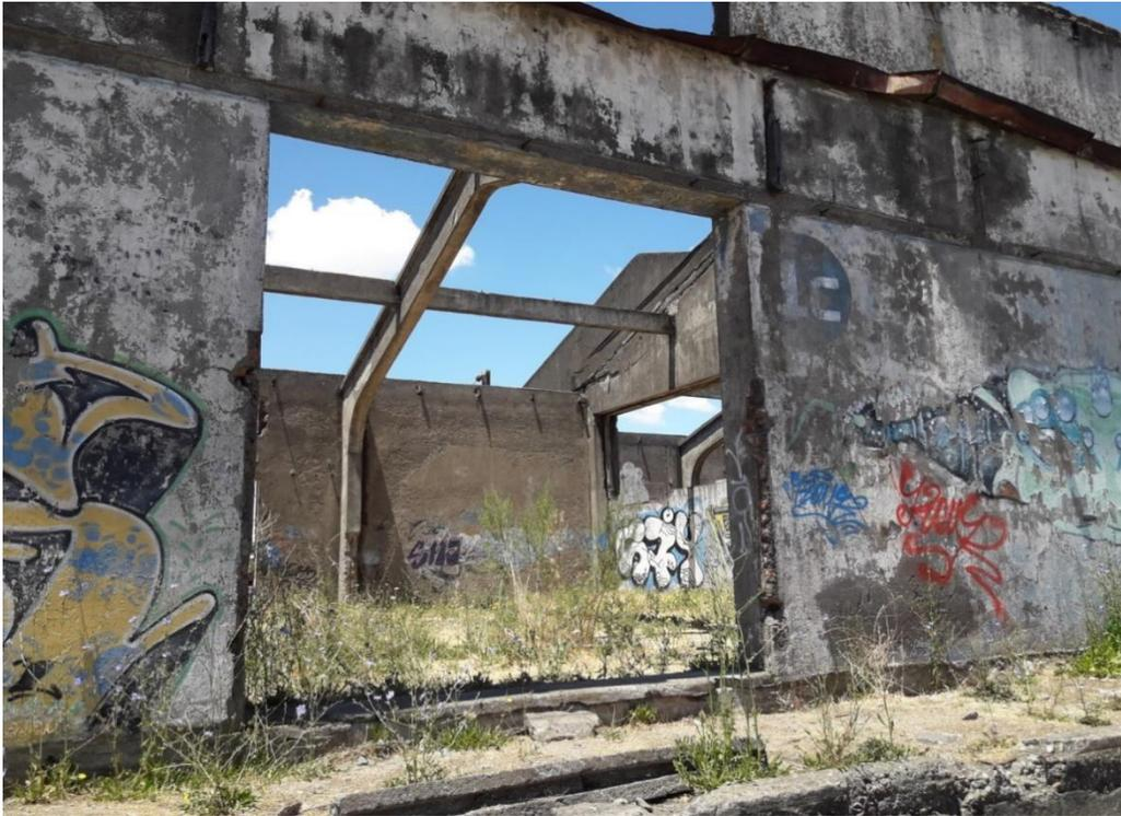
Las vigas existentes en los ejes longitudinales se encuentran en buenas condiciones.
