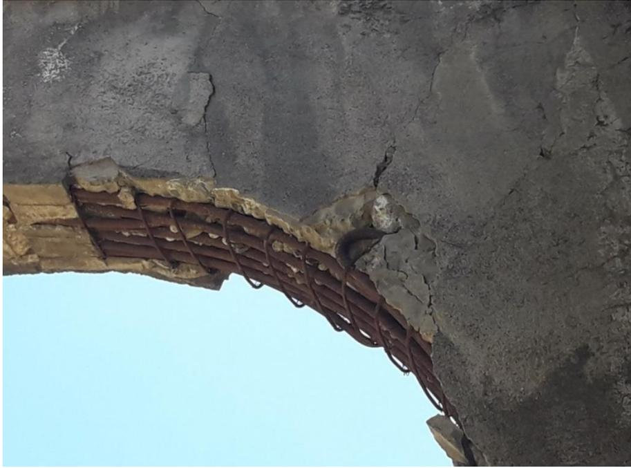
La armadura de los pilares y de las vigas, en todo su desarrollo, muestran sistemáticamente ciertas características particulares respecto a la disposición de armaduras, al disponer de escasa estribación, no presentar barras laterales y exhibir gran concentración de barras en primera capa.
