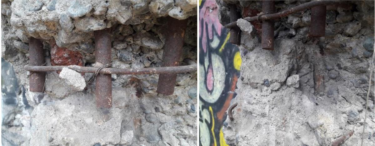
Para rehabilitar estructuralmente los marcos deberá reponerse la armadura vertical extraída, lo cual plantea una dificultad constructiva relevante ya que las barras nuevas deben embeberse en la masa de hormigón existente materializando traslapes eficaces con las armaduras que se conservan.
