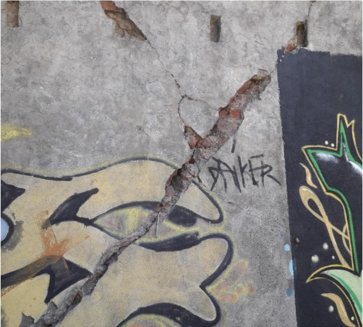
Fracturas en diagonal doble producidas por excesivo cizalle sísmico en el plano propio de muro transversal.
