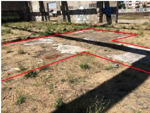
**Fig.60.** En esta imagen se puede apreciar un vestigio de radier ubicado en el cuerpo 1 del edificio, como se grafica en los planos de levantamiento.
