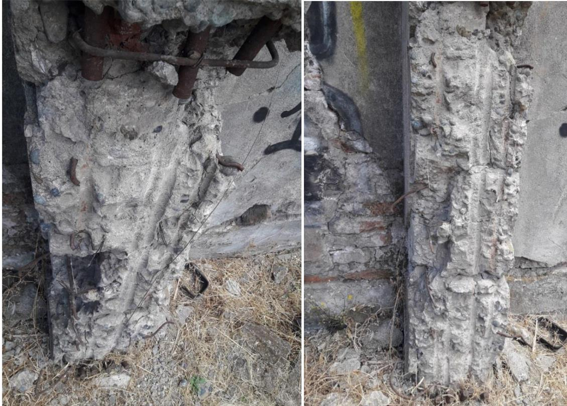
Al igual que en los hombros, las armaduras verticales de la base de los pilares quedaron a la vista como resultado de la sollicitación sísmica contenida en el plano propio, sin embargo, al quedar expuesta y al alcance de la mano, se produjo su extracción sistemática, generando una pérdida significativa al inmueble.
