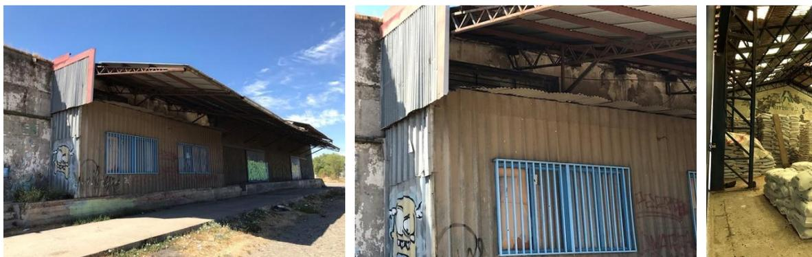
**Fig.55.** En la imagen de la izquierda se aprecia las características morfológicas y de materialidad discordantes e invasivas para el edificio original, del Galpón metálico adosado al cuerpo 4. La imagen del centro, es un detalle de la fachada que da cuenta de la precariedad de la construcción metálica y la imagen de derecha muestra una vista del interior en la cual se aprecia los sacos de fertilizantes.
