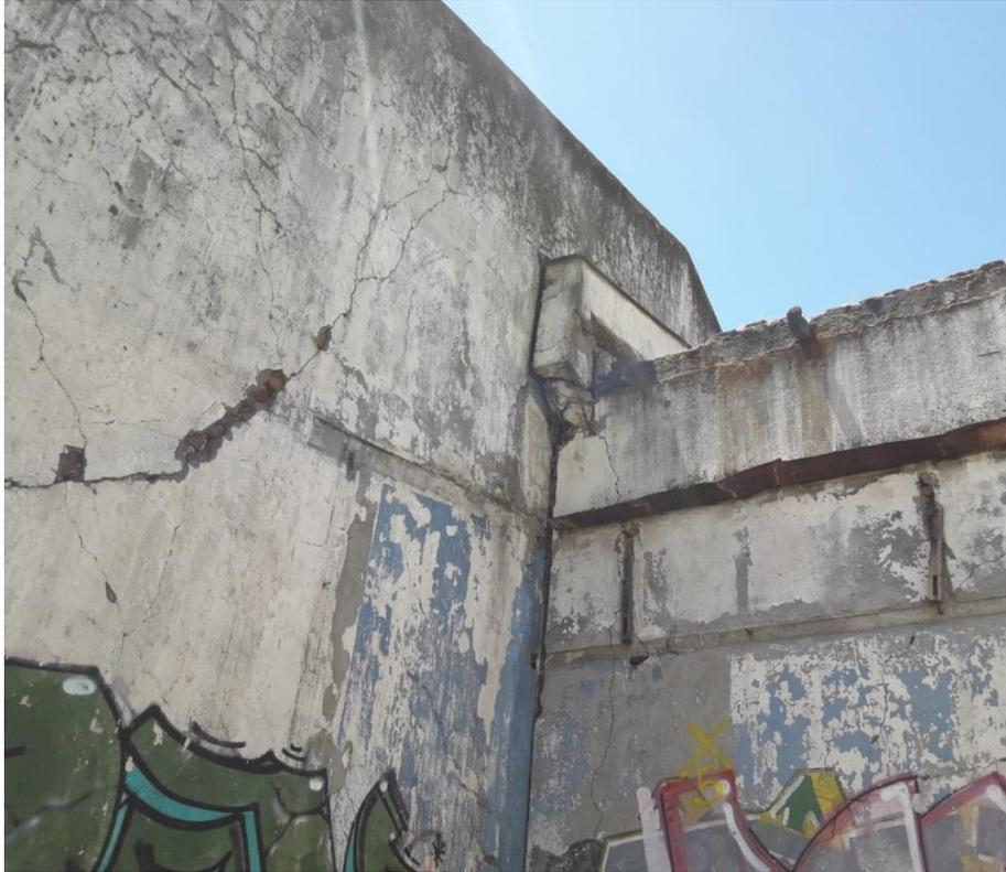
Densa fisuración en muro transversal producto del severo corte sísmico en el plano propio de muro transversal.
