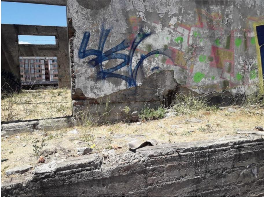
La fractura basal es sistemática en ambos muros longitudinales y se debe a la flexión lateral producida por la carencia de elementos estructurales capaces de controlar las deformaciones transversales de cada nave.
