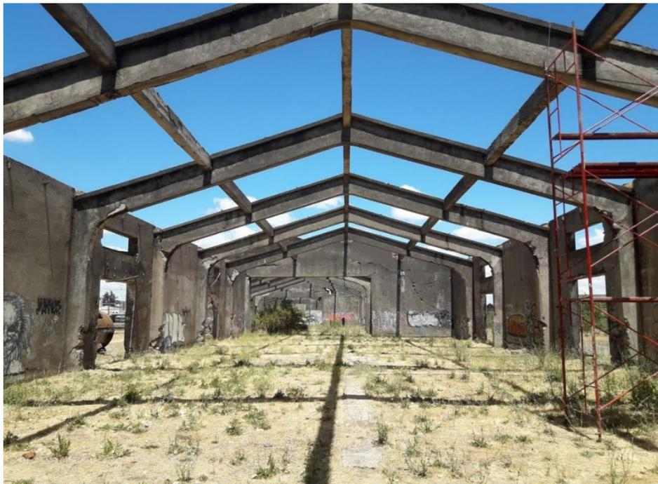
Vista general de nave norte que muestra los componentes de la estructura: Muros y vigas longitudinales; Marcos transversales; Muros transversales y Vigas secundarias longitudinales.
