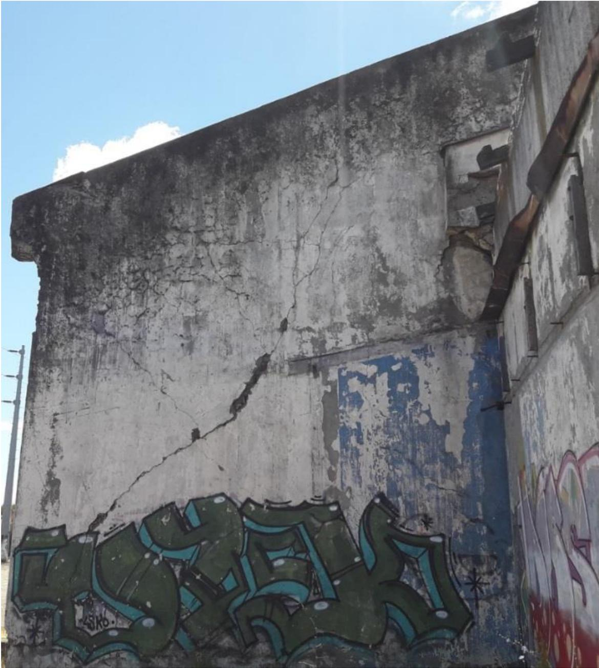
Muro transversal: Fractura diagonal derivada de corte sísmico excesivo en el plano propio.
