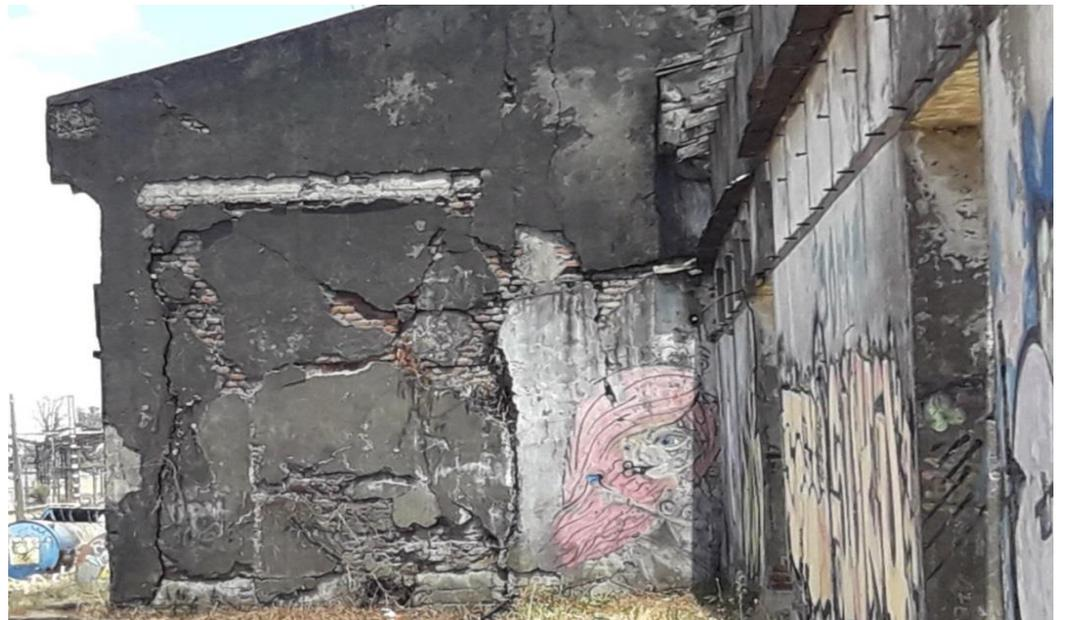
Los daños en los muros son sistemáticos. Acá se exponen las fracturas en doble diagonal derivadas del exceso de cortante sísmico en el plano propio.
