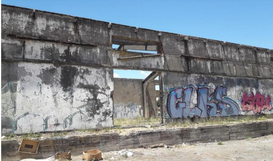
Los muros longitudinales concentran sus daños en su base donde se exhibe una fractura horizontal que abarca la mayor parte de su longitud.
