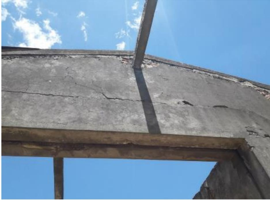
Todos los ejes contiguos a las juntas de dilatación presentan daño de origen sísmico consistente en separación de los frontones de albañilería, predominantemente simple, y las vigas de hormigón armado bajo ellos. La intensidad de los daños de estos elementos es variable de una nave a otra.
