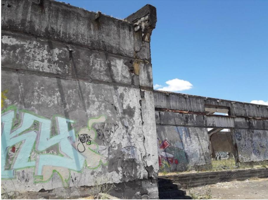
Los muros transversales presentan recurrentemente fracturas en diagonal simple o doble producto del excesivo corte sísmico en el plano propio y adicionalmente exponen separación de los pilares de hormigón armado ubicados en el encuentro de muros, generados por el exceso de deformación lateral de los muros longitudinales.
