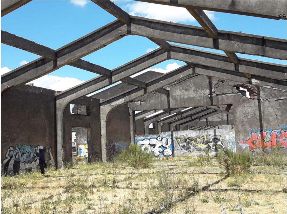
El muro marco de la imagen muestra vaciamiento sísmico de carácter grave. En la página siguiente se expone una imagen que se focaliza en el vaciamiento sobre el muro.
