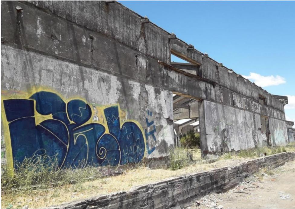
La fractura basal longitudinal es consecuencia directa de la excesiva deformación lateral dado el hecho que no tienen capacidad para controlar eficazmente el desplazamiento transversal de los muros longitudinales.
