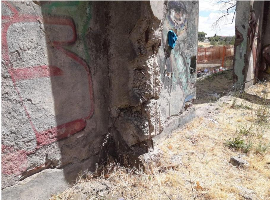
De manera recurrente las naves exhiben un corte horizontal a nivel de sobrecimiento, debido a flexión lateral producida por la falta de rigidez transversal.
