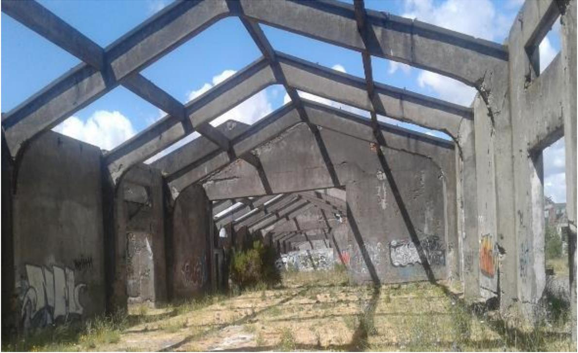
Este muro transversal exhibe separación de la masa de la albañilería que constituye el frontón y la viga que la soporta.
