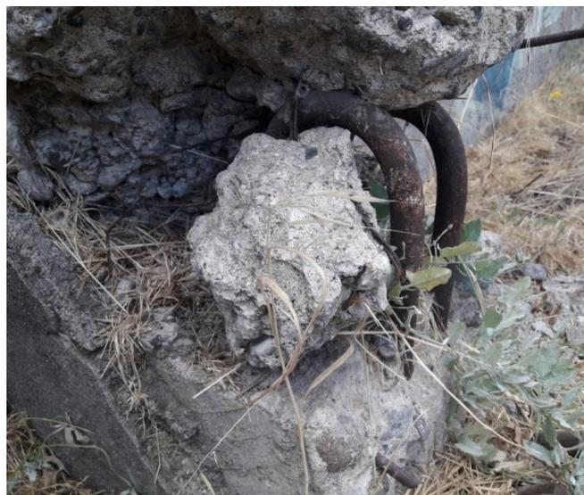
En esta imagen se muestra el doblez de dos barras verticales que nacen del cimiento, lo que no corresponde a un daño antrópico sino que a una falencia de diseño.
