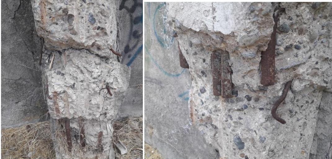
La extracción de parte de las armaduras verticales de los pilares constituye una lesión antrópica severa porque resta capacidad estructural esencial a los pilares que son deficientes incluso con sus armaduras completas.
