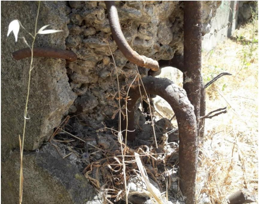
La configuración de las armaduras es idéntica en todos los pilares de los marcos transversales, tanto en relación a su disposición como de sus carencias.
