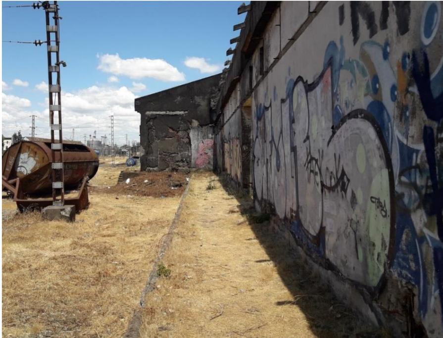
La base de los muros longitudinales presenta fractura horizontal derivada del exceso de deformación transversal producto de la falta de rigidez en esa dirección.
