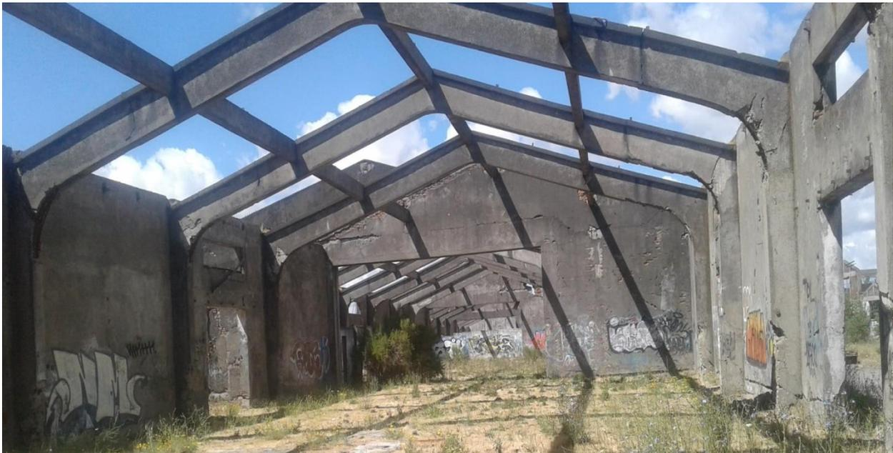
Todas las naves presentan una estructuración similar en la cual hay marcos transversales interiores de hormigón armado, exhibiendo una forma estándar industrial de pilares y vigas a dos aguas. Sus daños son sistemáticos y se pueden describir según lo siguiente:
