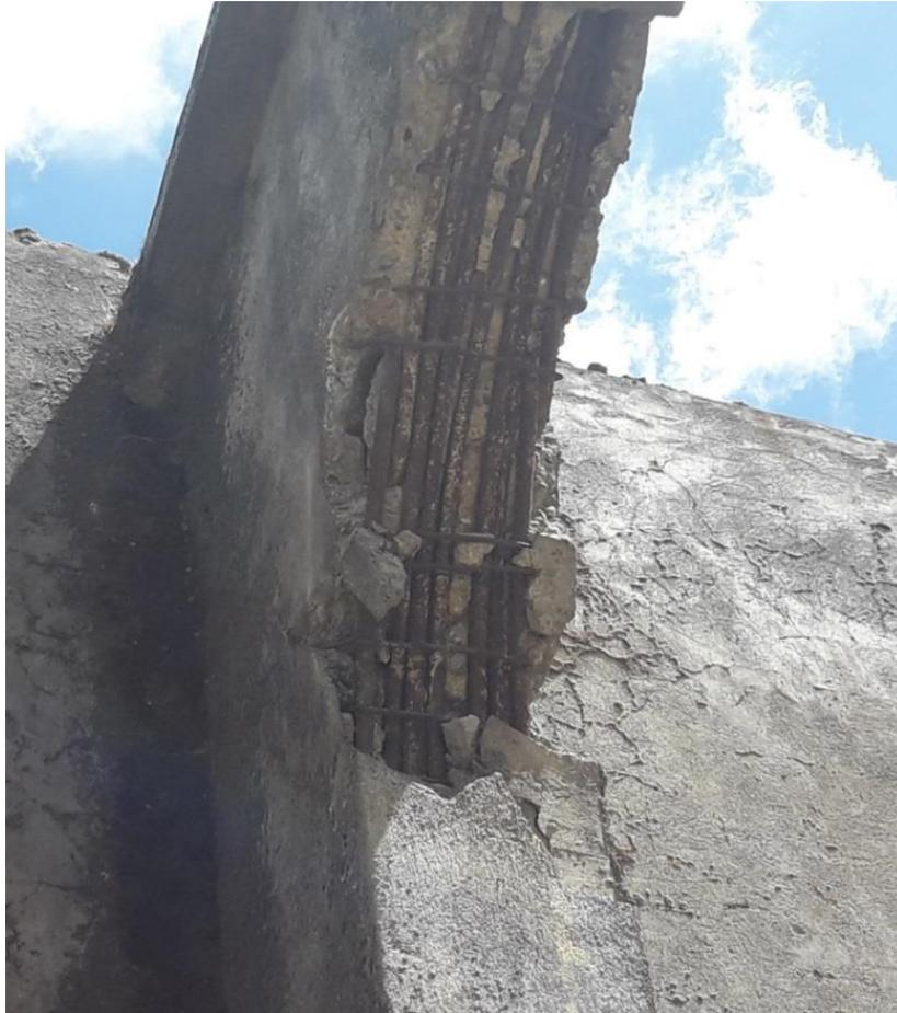
La sección de hormigón es insuficiente para albergar tal cantidad de fierros en flexión, por cuanto la proximidad de éstos afecta la adherencia de la armadura con respecto al sustrato pétreo.
