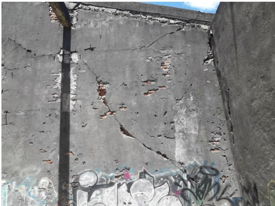
Grietas por corte sísmico excesivo en muros transversales.
