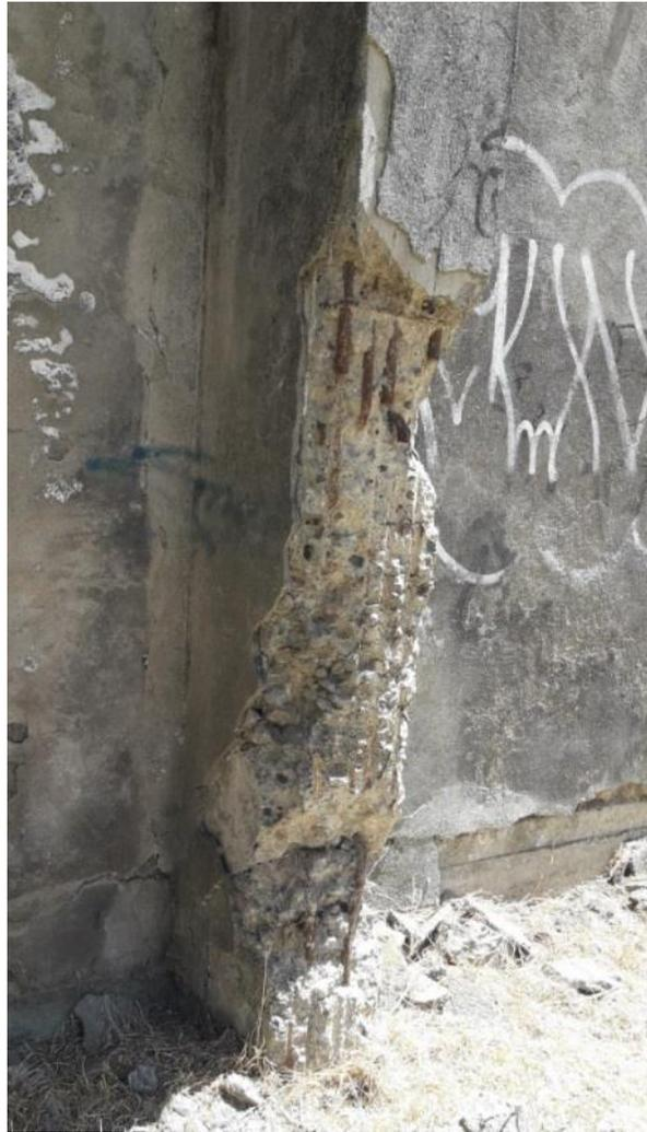
En esta imagen se muestra dos daños sistemáticos y severos del edificio: a) La extracción de las barras verticales en la parte basal de los pilares de los marcos transversales y b) la grieta horizontal basal de los muros longitudinales.
