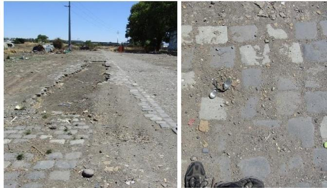
**Fig.61.** La imagen de la izquierda muestra los vestigios del pavimento de adoquines que existen en la denominada calle Italia contigua al edificio de bodegas. A la derecha se aprecia un detalle de los adoquines.
