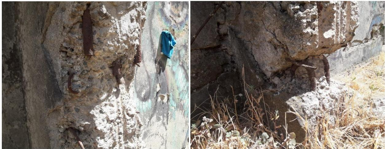
La extracción antrópica de las armaduras verticales interiores es sistemática.
