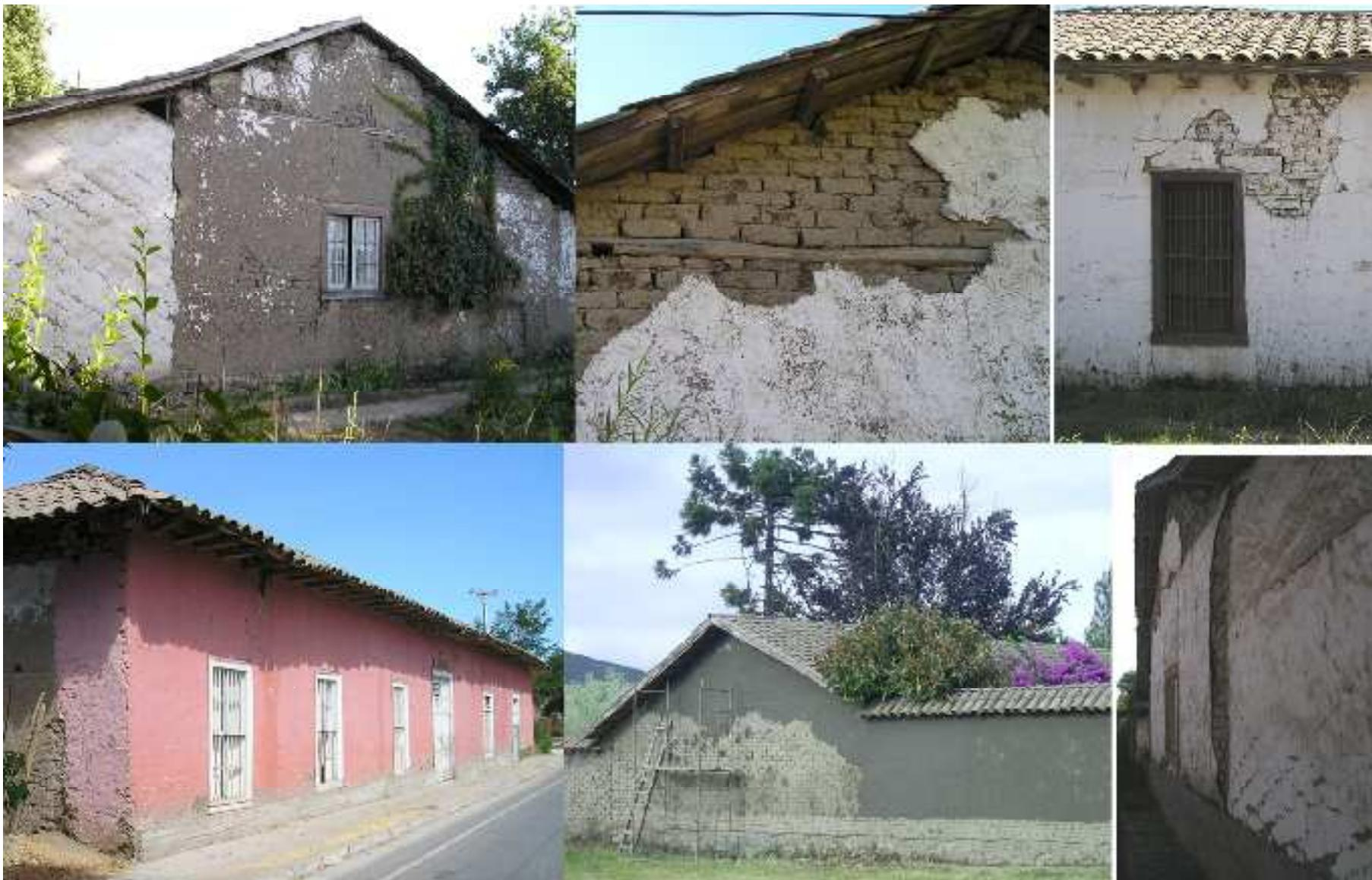
Imagen 220-225: Construcciones existentes en Zúñiga de adobe.
