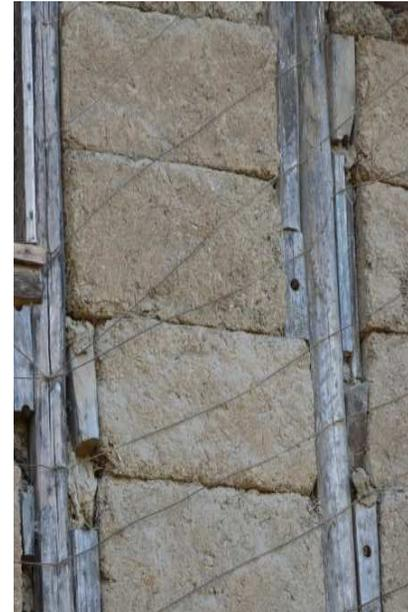
Imagen 231: Bloques de adobe con los que se realizan los muros exteriores. Fuente: Elaborada por autor.
