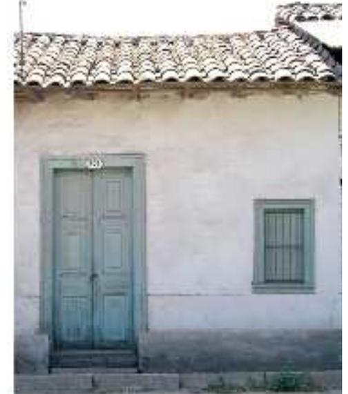
Imagen 232: Casa de adobe con zócalo, muro de adobe de 70 cm., tejas de barro y marcos de madera. Fuente: Elaborada por autor.
