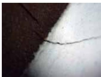
*Foto 11: Fisura de la base de preparación debida a la fractura de la madera.*
